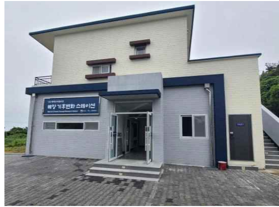
< 스테이션 건물 전경 >
